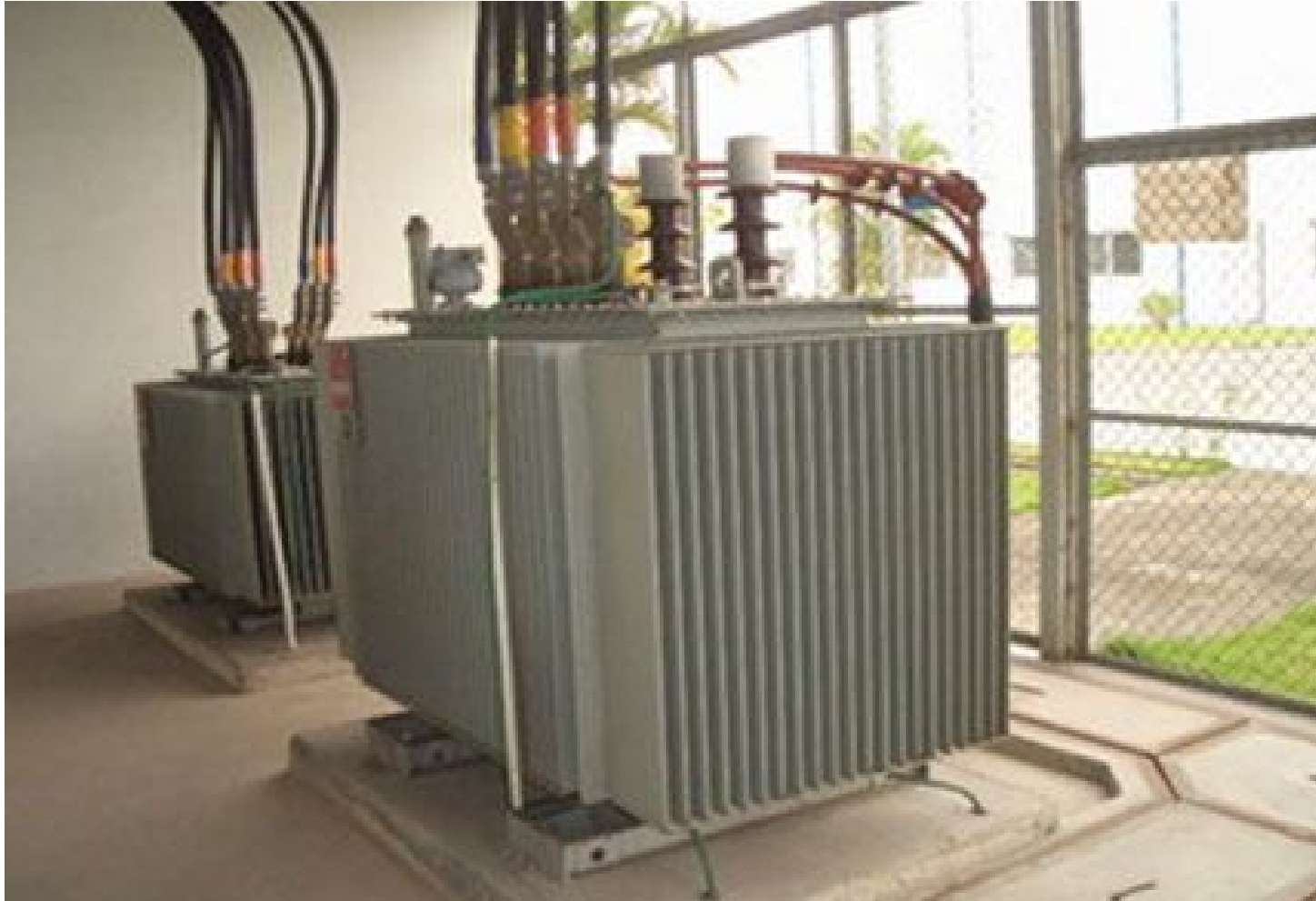
Hình ảnh máy biến áp vận hành song song tại trạm biến áp
