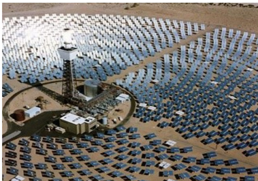
Hình 1.3.9 . Nhà máy điện nhiệt Mặt trời 100MW ở Nam Phi
