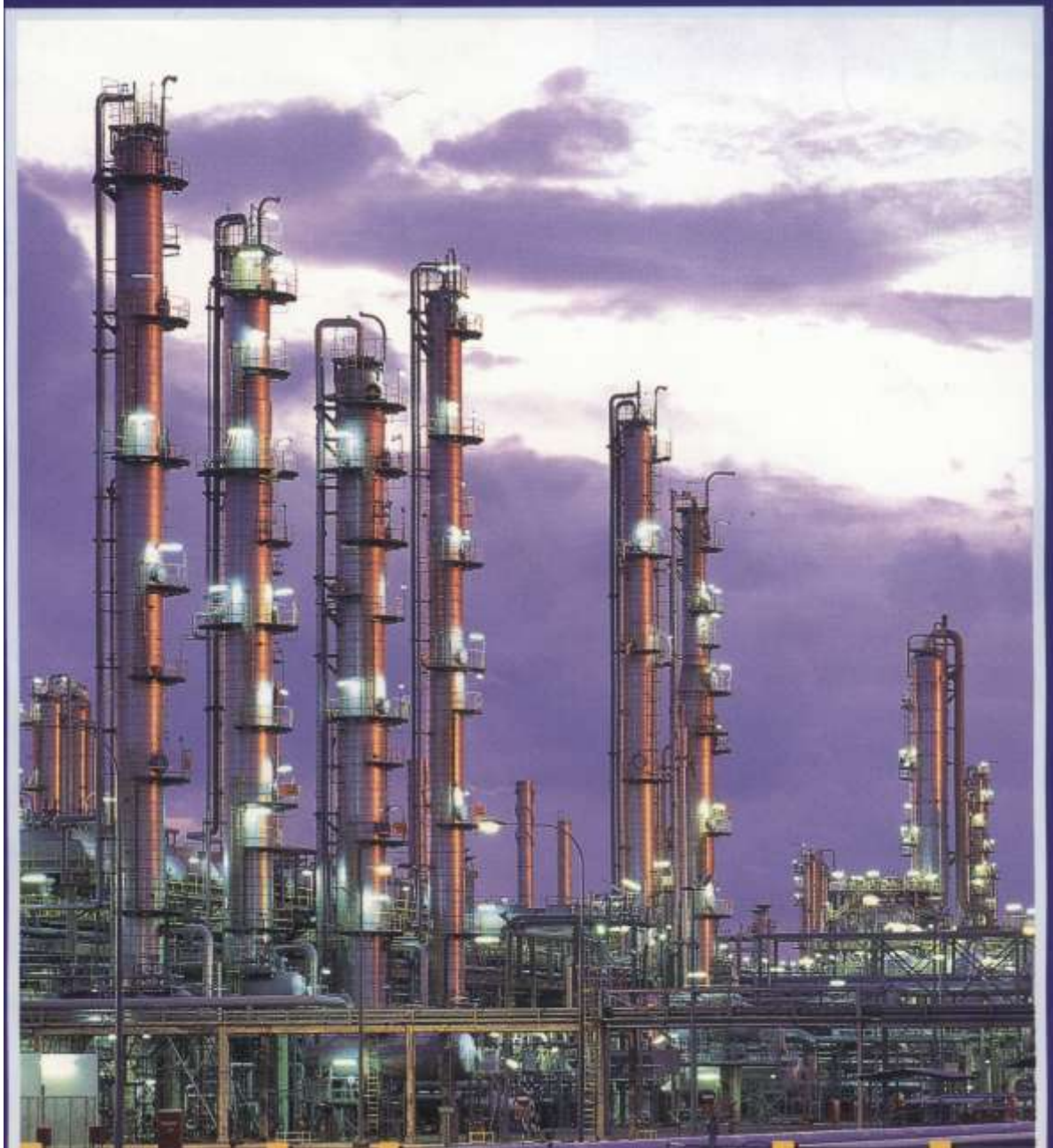
Hình 3.23. Phân bố các tháp chưng cất trong nhà máy lọc- chế biến dầu.
