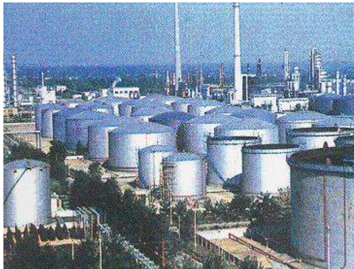
Hình 24 B- Bể chứa mái cố định
