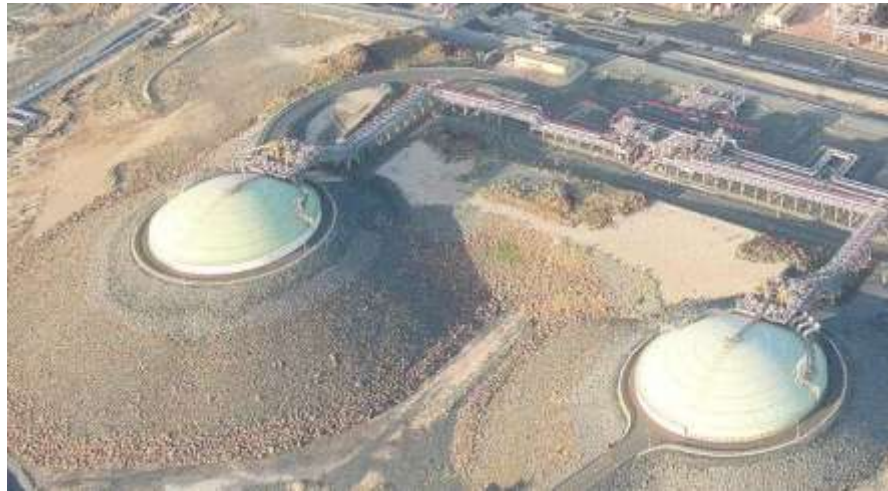
Hình H-23B Bể chứa khí hóa lỏng chớm
