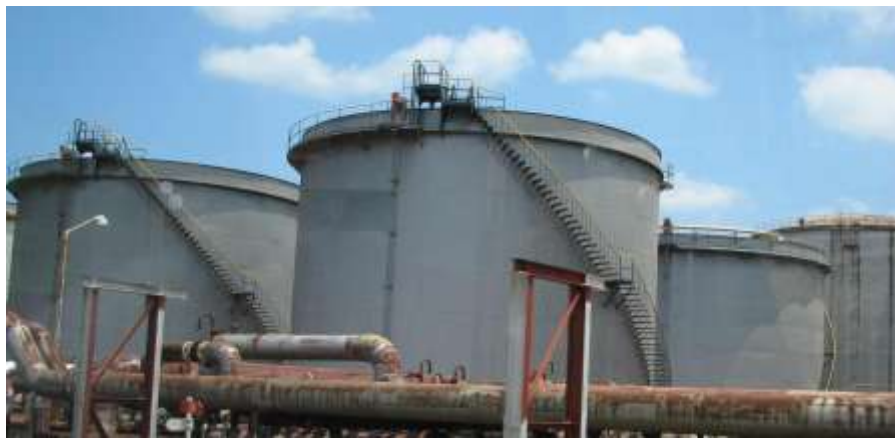
Hình 24 A- Bể chứa mái phao nổi
