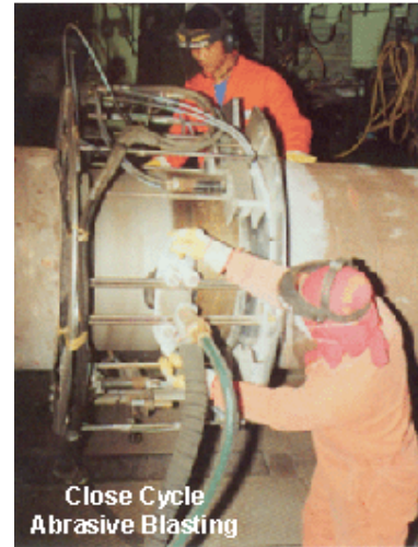
Nối ống tại công trường
