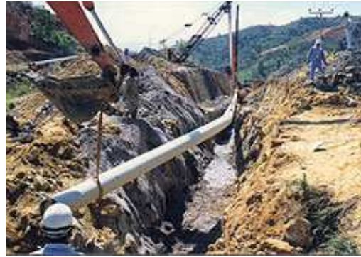
Quá trình đào rãnh
