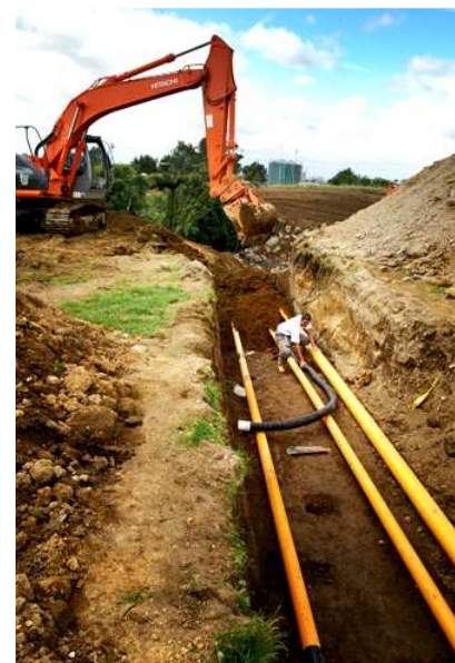
Quá trình lắp rãnh
