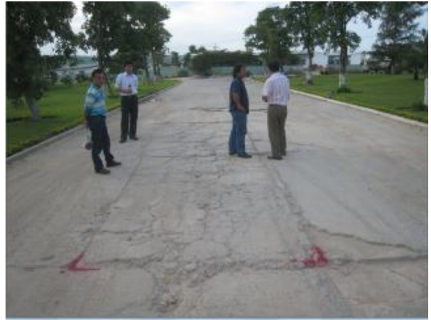
Xác định khu vực hình thành các vết nứt và vị trí vào công trình xây dựng của Trụ sở Lý
