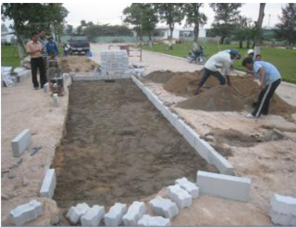
Đào bêtông hình thành, thi công đá vôi xung quanh và làm lớp cát gia cố xi măng
