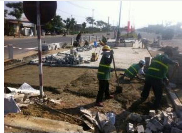
Làm l p v a m và lát g ch b ng th công
