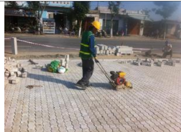
Làm l p v a m và lát g ch b ng th công
