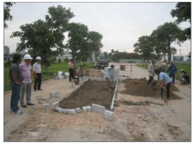
Đào bêtông hình thành, thi công đá vôi xung quanh và làm lớp cát gia cố xi măng
