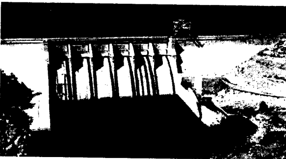
Hình 7.4. Đập bằng bê tông chảy theo lức trong trường
