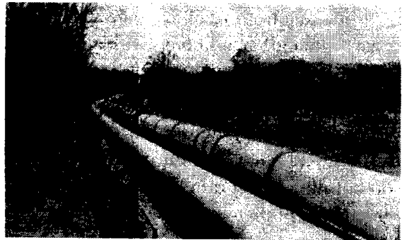
Hình 7.14. Đường ống thép đường kính lớn dùng để vận chuyển nước uống
