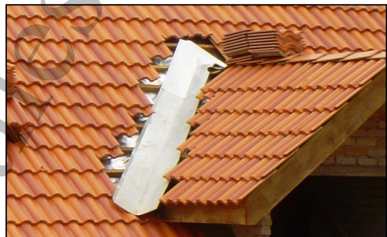
Những viên ngói chính cần phải được cắt và tạo hình sao cho che phủ 1 phần máng xối
