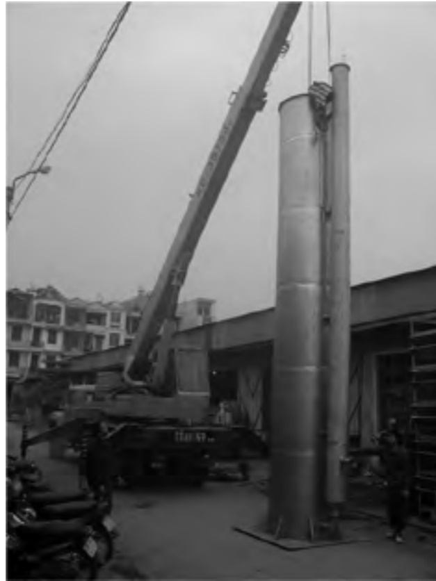
Hình 4.1. a. Mô hình pilot công suất 15 m 3 /ngđ; b. Lắp ráp thiết bị lọc công suất 100 m 3 /ngđ
