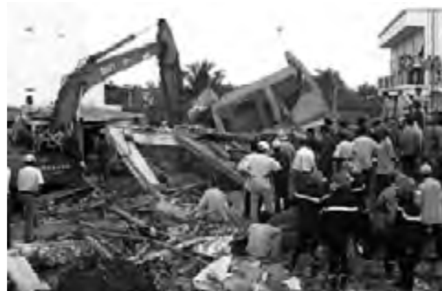
Hình 3. Sập nhà ở Long An do thi công tự ý nâng thêm tầng
