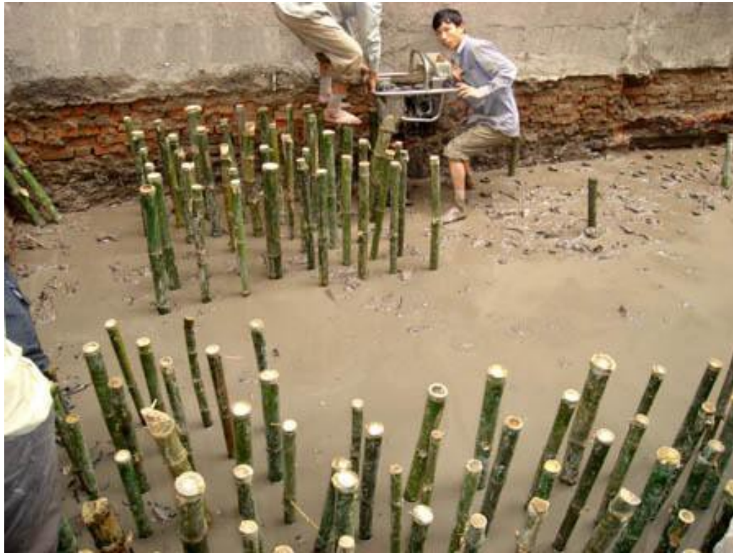
Thi công ép cọc tre bằng máy
