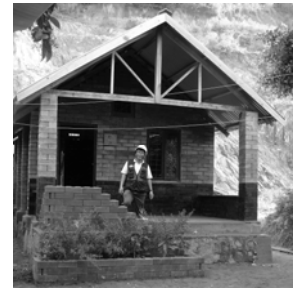
Hình 2: Căn nhà hoàn tất sau 10 ngày thi công
