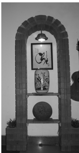
Hình 33: Gạch ICEB có thể dùng làm hốc tường trong nội thất.
