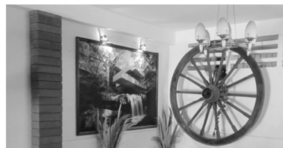
Hình 31: Gạch ICEB được dùng làm bộ trụ - một hình thức phân chia không gian trong trang trí nội thất
