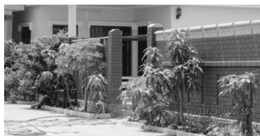
Hình 25: Tường rào cho công trình nhà ở tại xã Nhơn Đức, huyện Nhà Bè, TP. Hồ Chí Minh.
