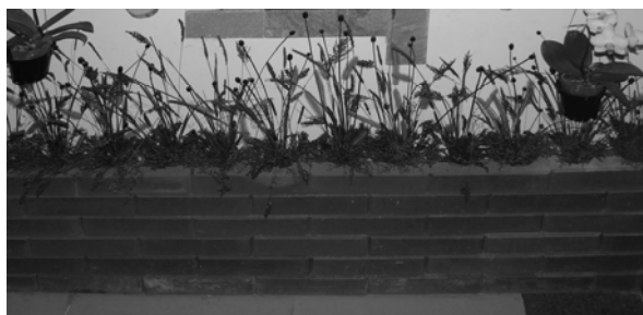
Hình 32: Gạch ICEB có thể dùng làm ốp chân tường trang trí.
