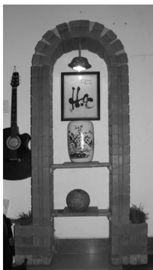
Hình 32: Gạch ICEB có thể dùng làm ốp chân tường trang trí.
