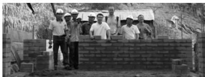
Hình 1: Căn nhà đang trong giai đoạn xây dựng
