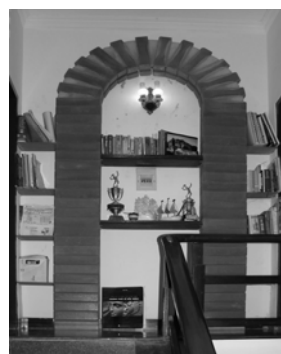
Hình 34: Gạch ICEB có thể dùng làm vòm trang trí trên tường để treo tranh hay kệ sách.
