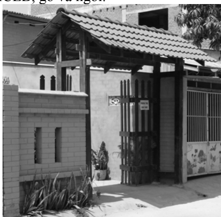
Hình 24: Tường rào và cổng cho công trình nhà ở tại khu phố 7, thị trấn Nhà Bè, huyện Nhà Bè, TP. Hồ Chí Minh.
