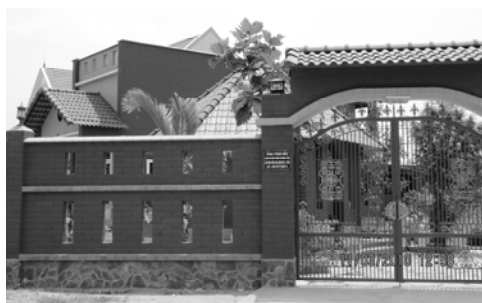
Hình 23: Tường rào và cổng cho công trình nhà ở tại xã Nhơn Đức, huyện Nhà Bè, TP. Hồ Chí Minh.
