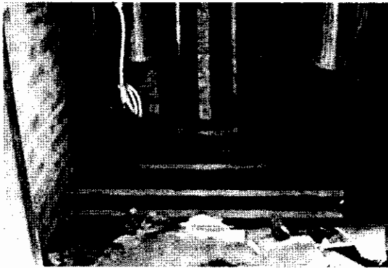
Hình 1.9: Hộp kỹ thuật cho ống cấp nước
