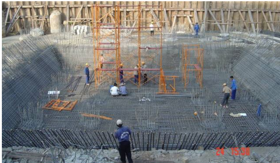
Hình 2.14 Móng bè trên cọc khoan nhồi.
