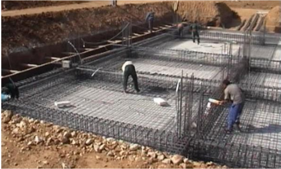
Hình 2.12 Thi công thép móng bè.
