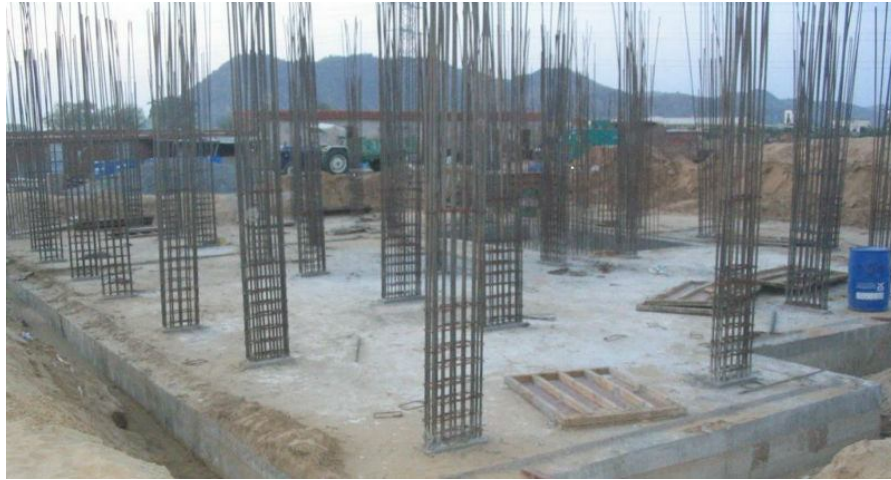
Hình 2.13 Móng bè sau khi thi công xong
