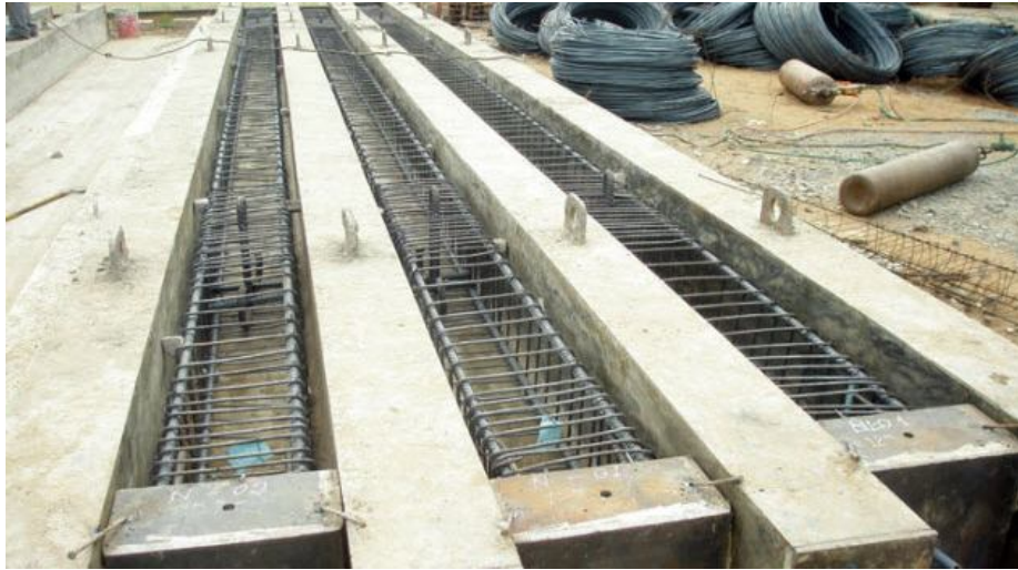
Hình 3.6 Thi công thép cọc
