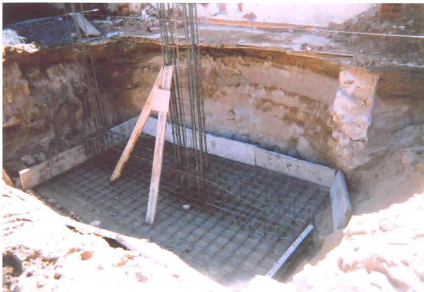
Hình 2.28 Thi công móng đôi
