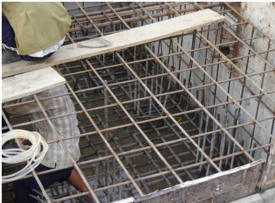
Hình 3.15 Thi công thép đài cọc.
