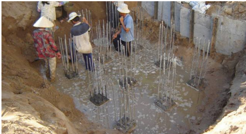
Hình 3.18 Cách bố trí 12 cọc ngoài thực tế thi công
