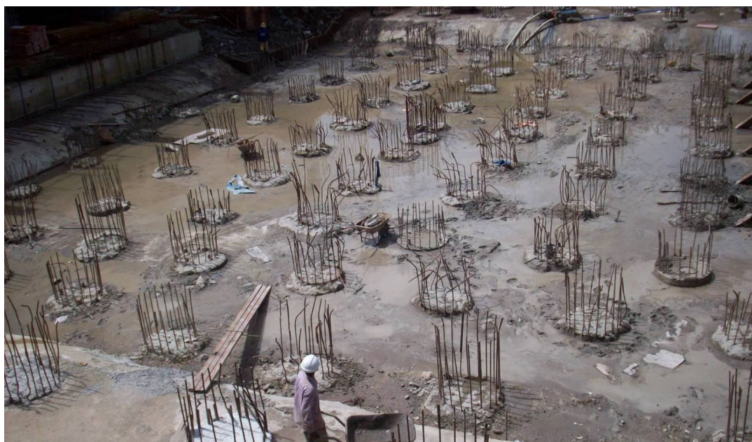
Hình 1.7 Thi công móng cọc khoan nhồi
