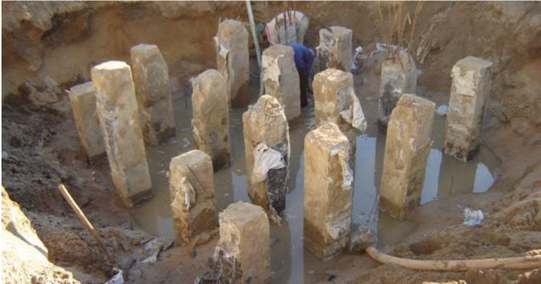
Hình 1.5 Thi công móng cọc ép
