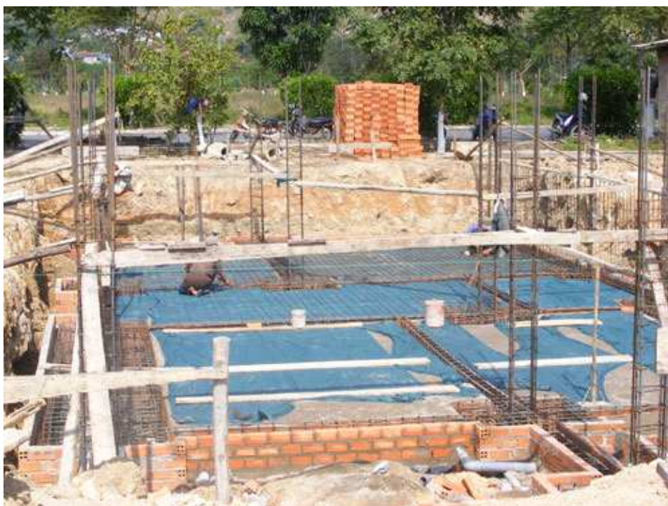
Thi công tầng hầm nhà DL-C22 – Công ty Trần Việt thực hiện
