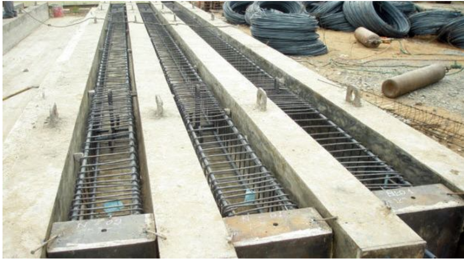
Hình 3.6 Thi công thép cọc
