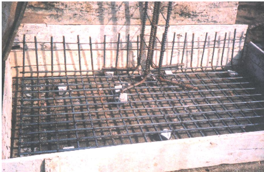
Hình 2.3 Thi công thép móng đơn lệch tâm lớn
