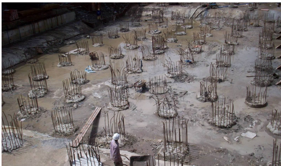
Hình 1.7 Thi công móng cọc khoan nhồi
