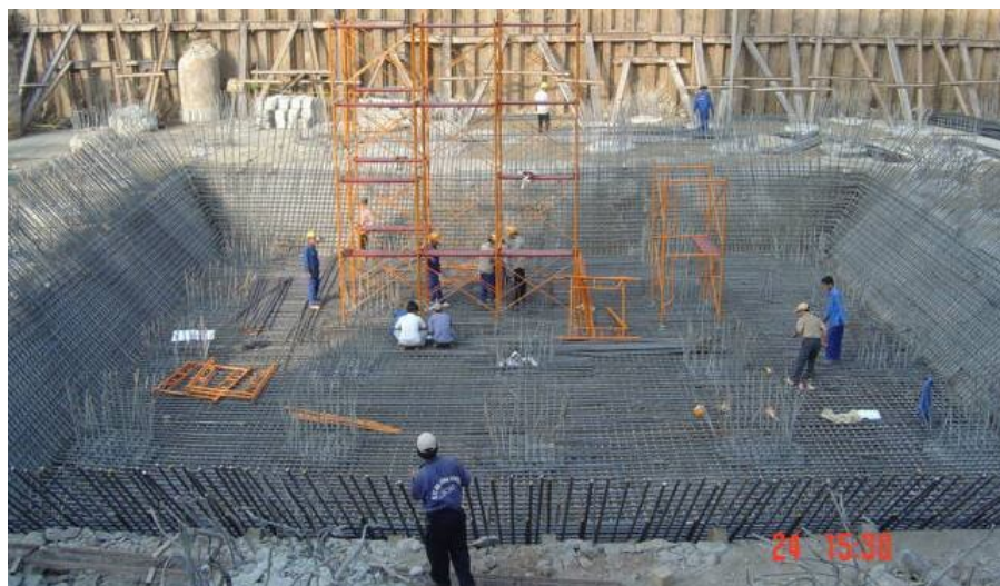
Hình 2.14 Móng bè trên cọc khoan nhồi.
