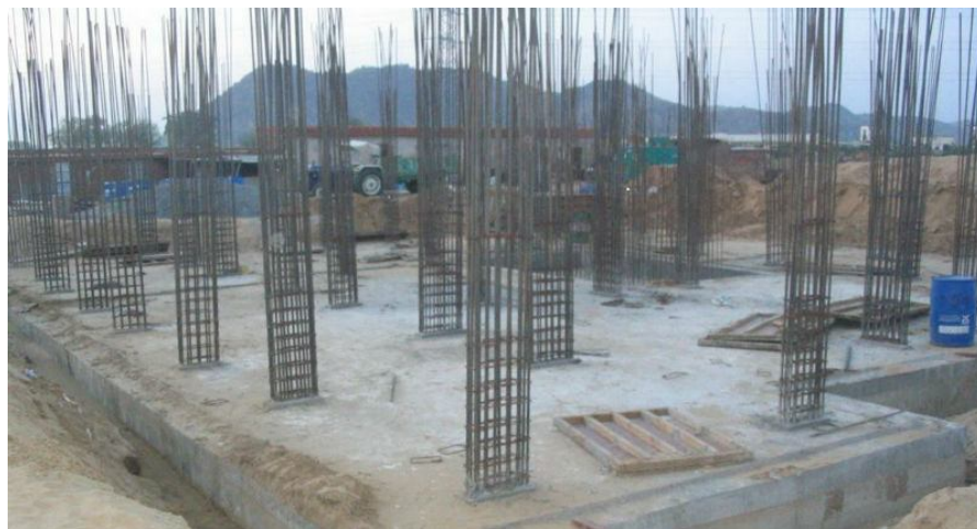
Hình 2.13 Móng bè sau khi thi công xong
