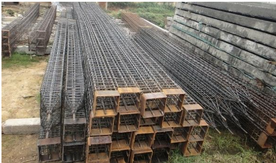
Hình 3.8 Công trường thi công thép cọc.
