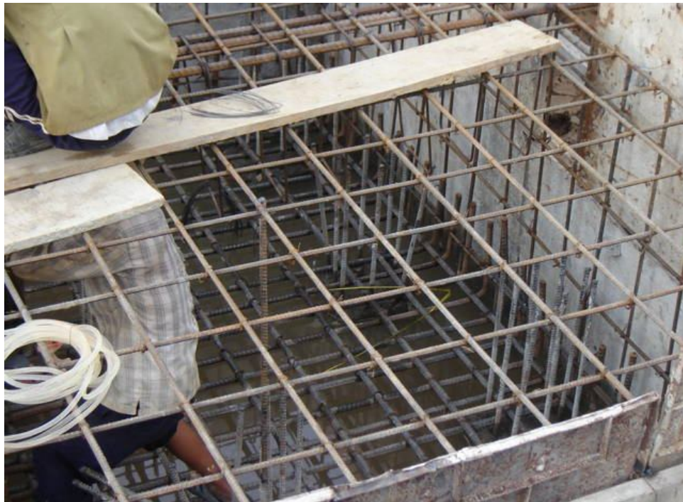
Hình 3.15 Thi công thép đài cọc.
