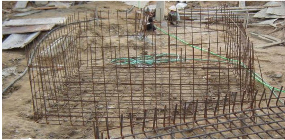
Hình 3.14 Lưới thép cấu tạo bên trên đài cọc.
