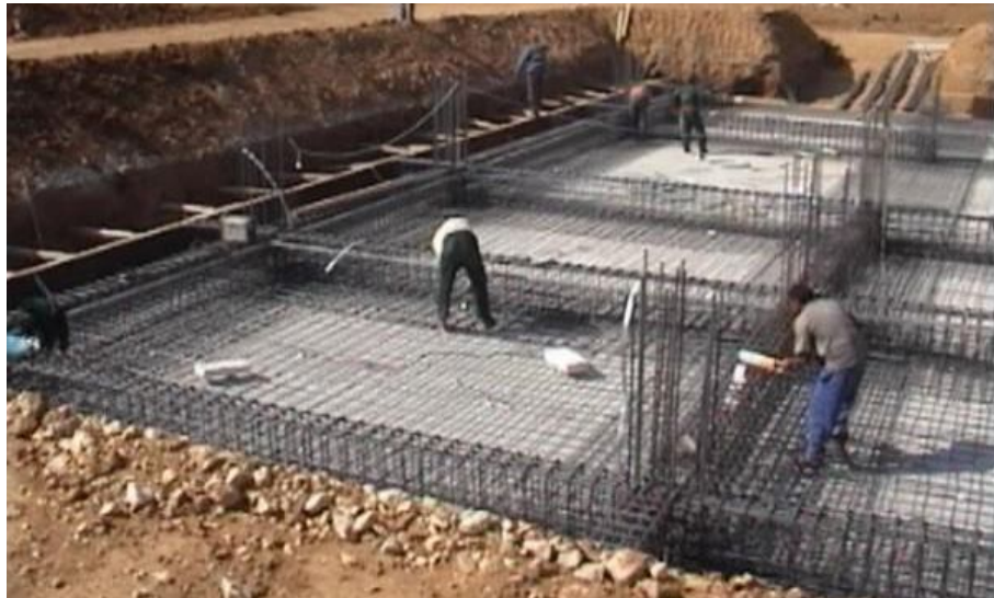
Hình 2.12 Thi công thép móng bè.
