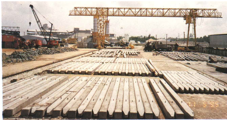
Hình 3.10 Bãi đúc cọc
