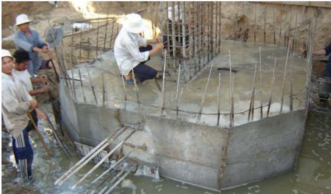
Hình 1.6 Một đài cọc sau khi đổ bê tông xong
