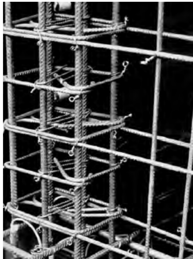
Hình 11. Cột thép ngang – đai và thang giằng ở góc của tường bê tông cốt thép là ví dụ điển hình cho việc uốn góc neo góc 135°. Tuy nhiên, khoảng cách theo phương thẳng đứng của các cột thép này quá lớn, s = 7,5d thay vì s \leq 5d như yêu cầu
