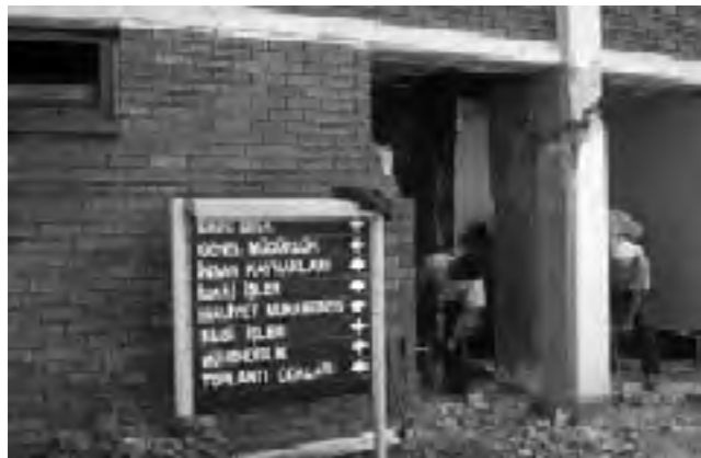
Hình 7. Phần tường phía dưới cửa sổ bên phải đã gây ra hiện tượng cột ngắn làm cho cột bị phá hoại cắt
