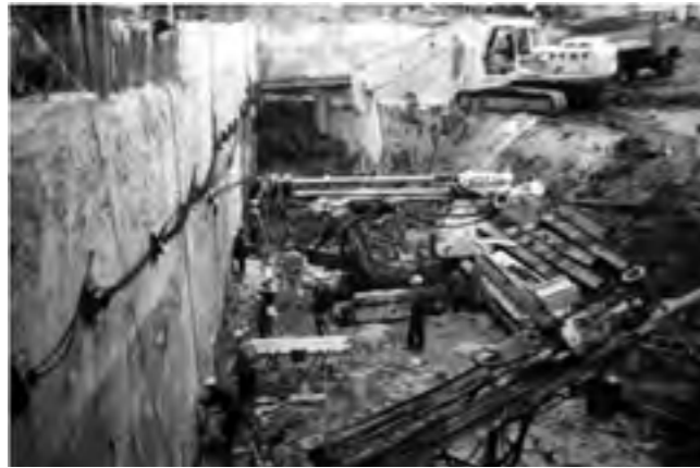
Hình 3. Tường bê tông kết hợp với neo trong đất (tòa nhà Vietcombank)
