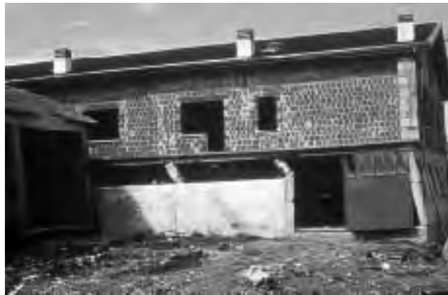
Hình 6. Khung chèn không đầy gây ra hiện tượng cột ngắn. Không có hiện tượng phá hoại cắt nhưng cơ chế dao động nguy hiểm đã xảy ra (Friaul, Italy 1976)
