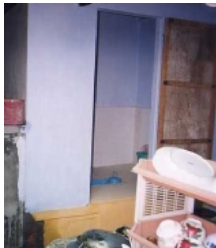
Hình 10: Nhà tiêu ST VinaSanres có thể xây trong nhà vì hoàn toàn không có mùi.
