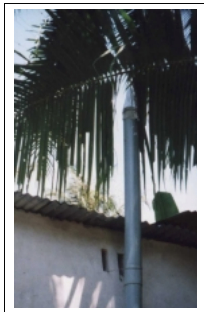
Hình 4 : Ống thông hơi càng cao càng hút hơi mạnh. Đầu ống có lưới ruồi hình nón nhọn, ngăn ruồi thoát ra , ngăn nước mưa rơi vào.
