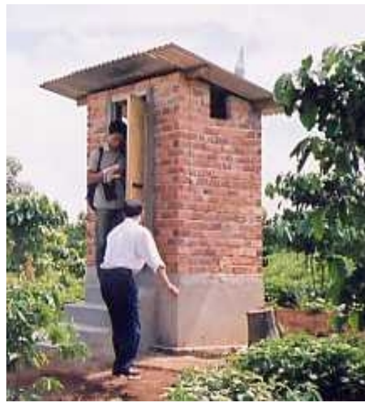
Hình 7: Nhà bao che xây gạch trần, cửa cốt ép để tiết kiệm kinh phí
