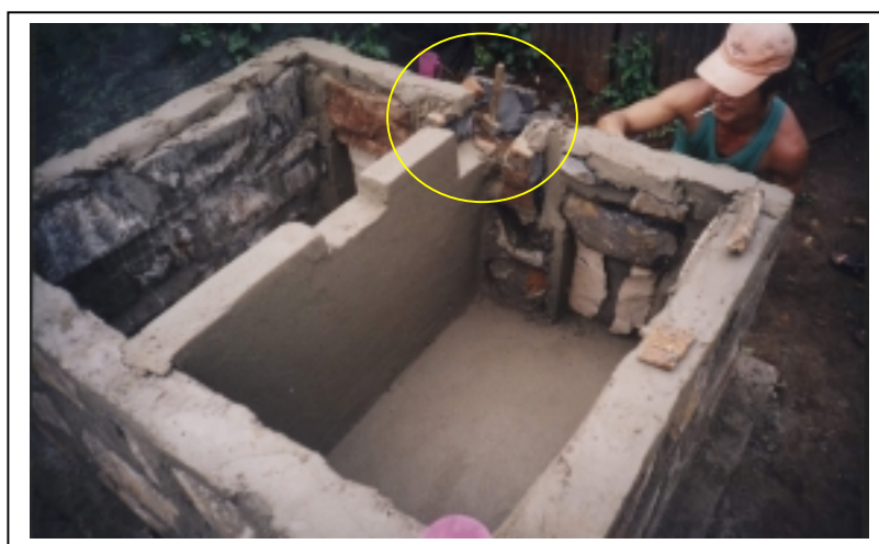
Hình 3 : Ngăn chứa phân xây bằng đá chẻ. Nơi được khoanh tròn là lỗ thông khí giữa hai ngăn và vị trí lắp nút ống thông hơi.
