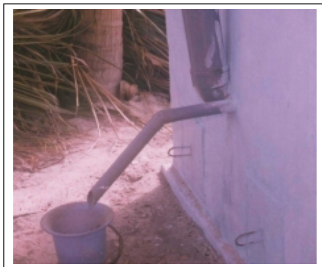
Hình 2 : Cửa lấy phân cần được trám kín. Cút ống thông hơi nằm ở vị trí cao nhất của ngăn.
