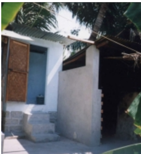
Hình 9: Nhà tiêu sát liền nhà để thuận tiện cho việc sử dụng và bảo quản.
