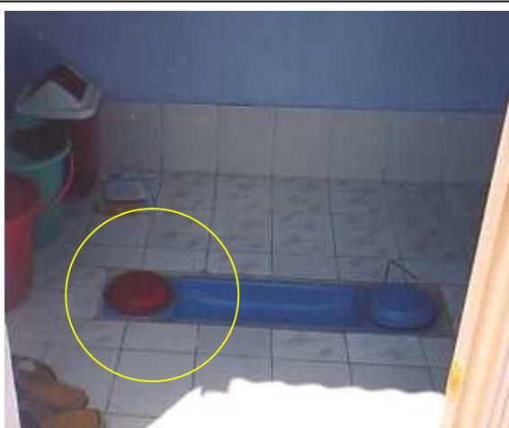
Hình 5 : Bệ tiêu bằng composit. Sự phân biệt rõ rệt giữa hai nắp sẽ tránh được nhầm lẫn khi đi tiêu.
