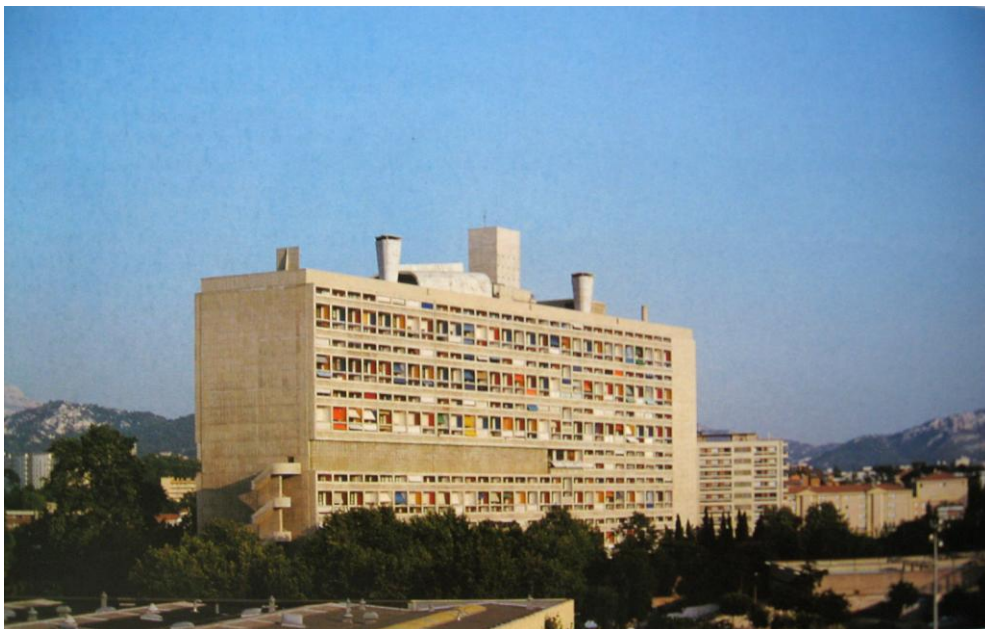
Hình 3: Nhà ở căn hộ chung cư tại Marseille (Cộng hoà Pháp)
