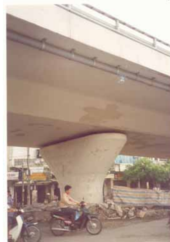
Hình 3. Trụ cầu Ngã Tư Vọng thể hiện công năng ổn định
