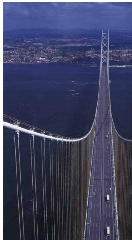
6. Cầu Akashi Kakyo (1998). Nhịp 1991m, kỷ lục thế giới nhìn từ đỉnh tháp.
