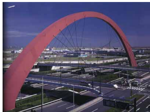
11. Cầu ở sân bay Haneka, Nhật Bản, hình chữ H, nhìn từ trên trời với 1 vòm ngang treo 2 dầm.
