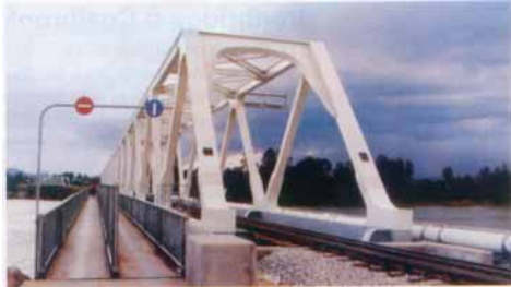
Hình 16 Cầu Bạch Hổ mới trên Đường sắt Bắc Nam
