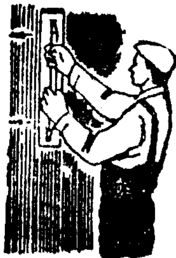
Hình I.19: Miết phẳng bằng bàn miết
