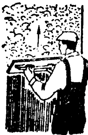
Hình I.19: Miết phẳng bằng bàn miết
