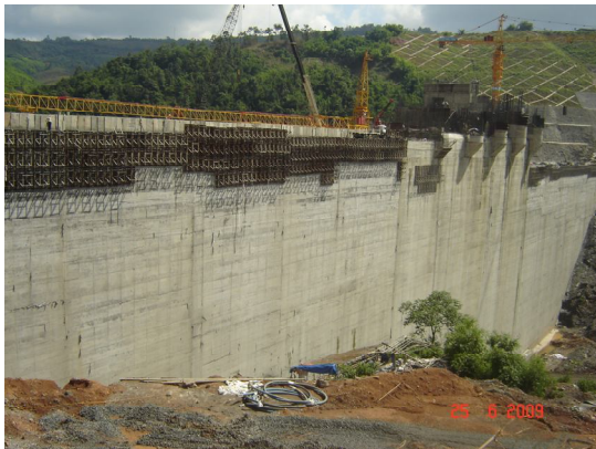
Hình 1. Xây dựng đập RCC thủy điện Đồng Nai 3 (Đắc Nông)
