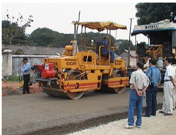
Hình 8. Thi công thử nghiệm mặt đường bê tông đầm lăn - IBST thực hiện 2001
