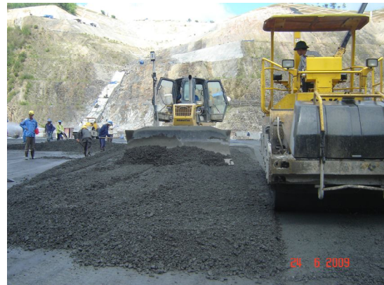
Hình 2. Thi công RCC đập thủy điện Đồng Nai 4 (Đắc Nông)
