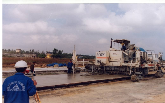
Hình 7. Máy rải bê tông liên hợp SP- 500 thực hiện công tác đầm và xoa hoàn thiện (ACC)
