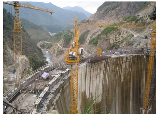
Hình 6. Thi công đập vòm công 2 chiều Nậm Chiến
