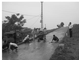
Hình 3: Quá trình sửa chữa dốc bê tông
