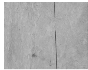
Hình 4: Mặt bê tông sau khi sửa chữa xong
