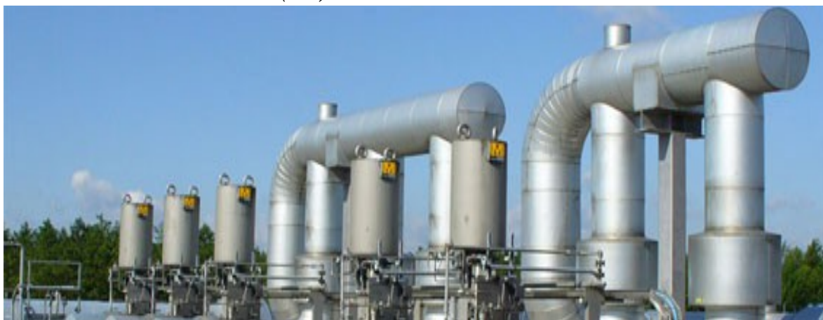
Hình 1.14: Hình ảnh nhà máy điều chế khí He
