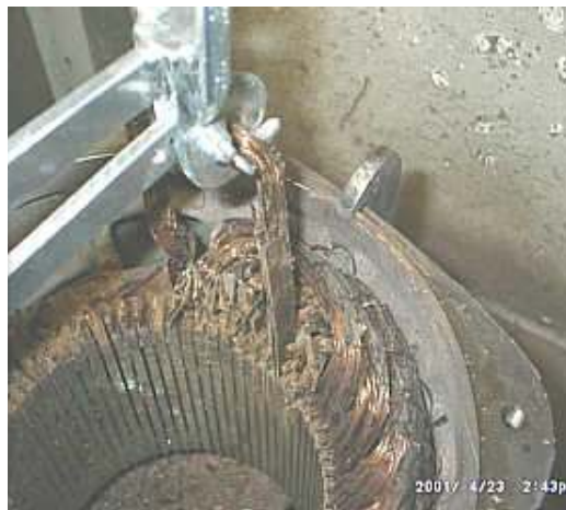
Hình 2-28. Rút dần từng búi dây ra khỏi lõi thép Stato
