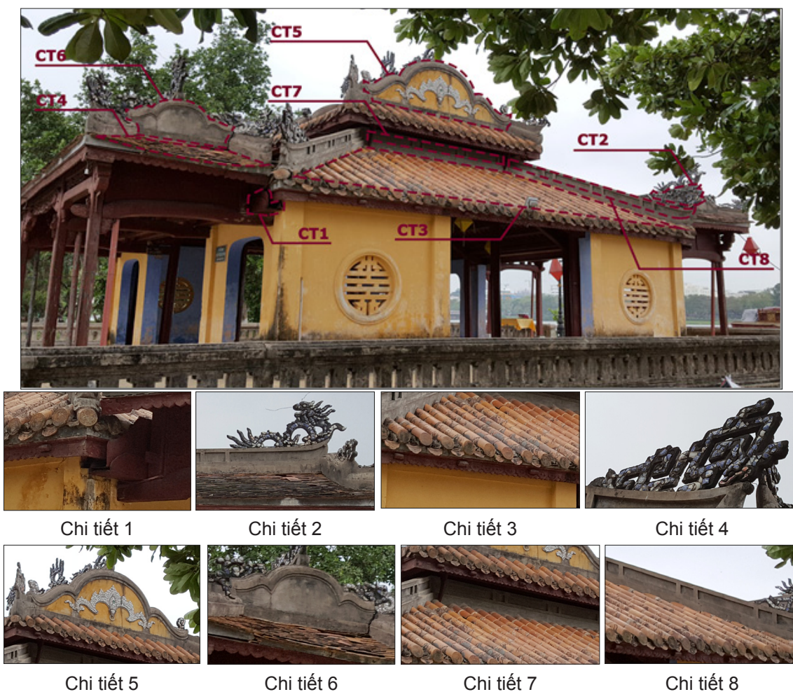
Chi tiết 1: Máng xối giữa nhà chính và nhà võ cưa; Chi tiết 5: Mặt tường đốc khánh nhà chính; Chi tiết 2: Con giống bờ quyết mái hạ; Chi tiết 6: Mặt tường đốc khánh nhà võ cưa; Chi tiết 3: Ngói mái nhà chính; Chi tiết 7: Ô hộc trang trí tường cổ diêm; Chi tiết 4: Ngói mái nhà võ cưa; Chi tiết 8: Ô hộc trang trí bờ quyết.
