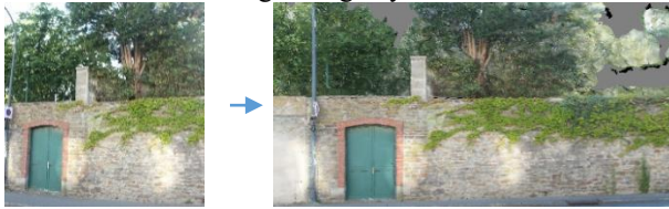
Hình 8. Vật liệu được thể hiện tốt trên mô hình Bức tường tại bên xe điện (mô hình của phần mềm Photoscan)
