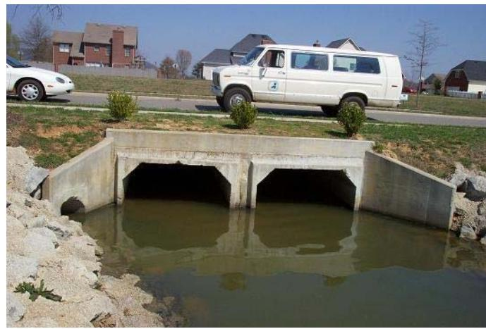
Cống ngầm mặt cắt hình hộp
