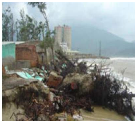
Hình 9: Khu vực bờ biển tại tổ 29 phường Hòa Hiệp Bắc (Q.Liên Chiểu, Đà Nẵng) đã bị sóng đánh gây sạt lở nghiêm trọng, đe dọa đến sự an nguy của hàng chục hộ dân.
