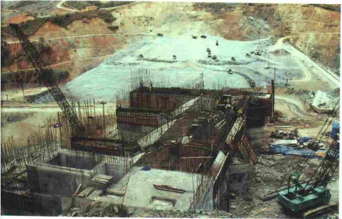
Thi công đập chính của thủy điện Xê Camàn 3 (Lào), công trình do Việt Nam thiết kế và xây dựng
