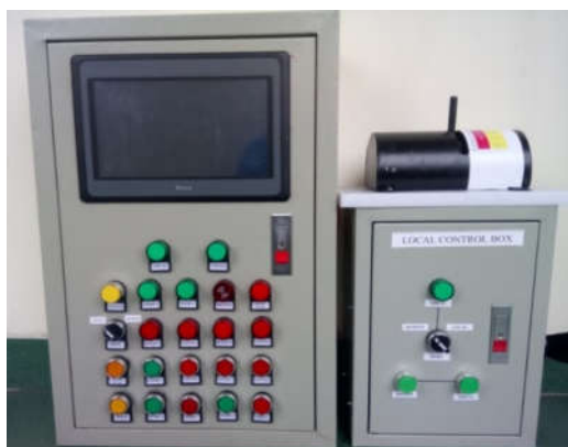
Hình 8. Hệ thống hoàn chỉnh khi xây dựng
