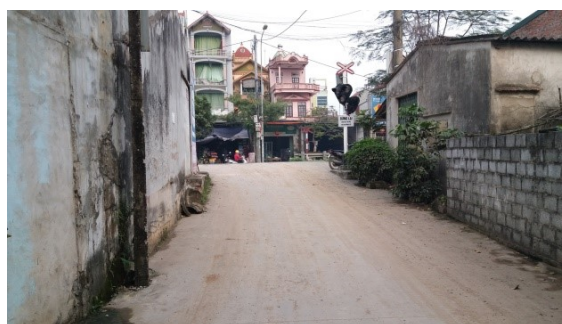
(b) Đường ngang tại Km34+175
