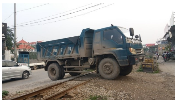
(a) Đường ngang tại Km32+80
