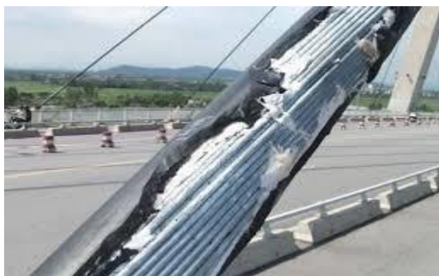
Hình 3. Hư hỏng dây văng do va chạm tàu ở cầu Bình (Hải Phòng)
