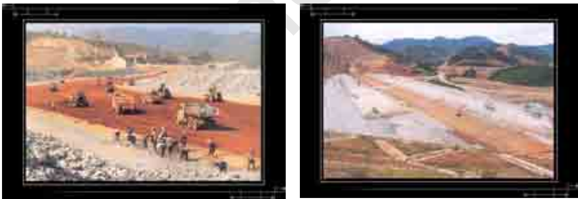
Hình ảnh thi công đập
