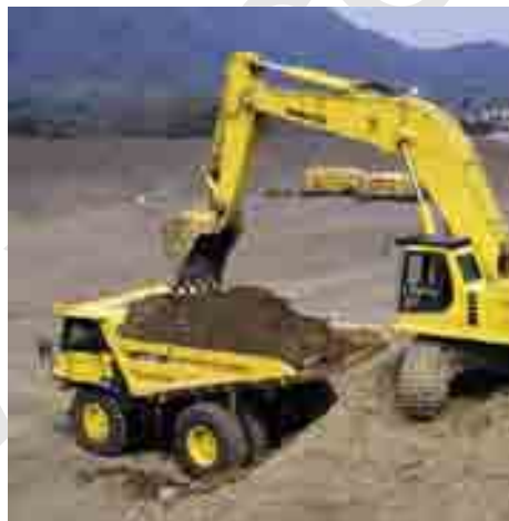
Đào và vận chuyển đất lên đập bằng máy đào gàu sập và ô tô tự đổ
