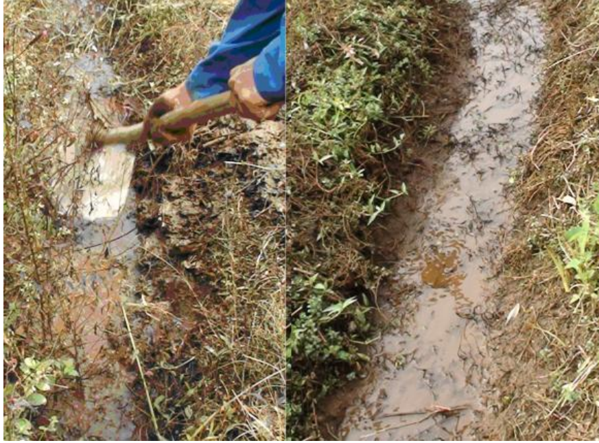
Hình 4.7.6: Nạo vét mương rãnh thoát nước trong mùa mưa
