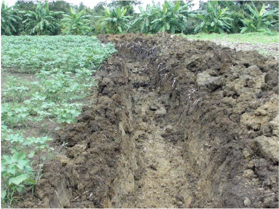
Hình 2.30: Mương thoát nước mới đào
