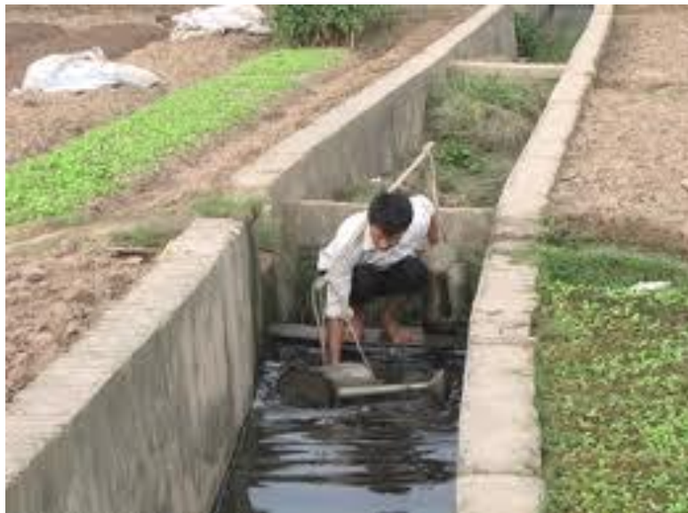
Hình 3.3.1: Hệ thống mương máng cung cấp nước
