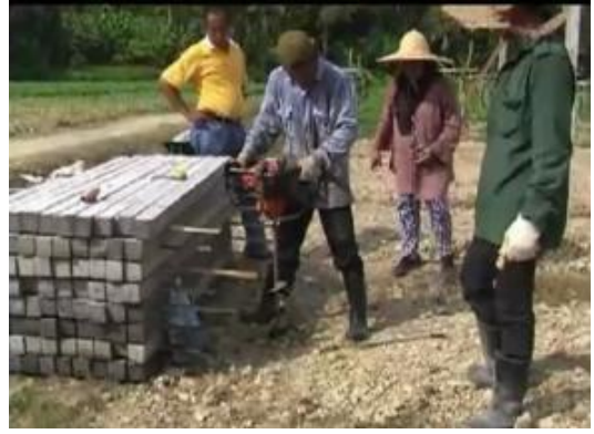
Hình 1.78. khoan lỗ trồng cột bê tông cốt thép
