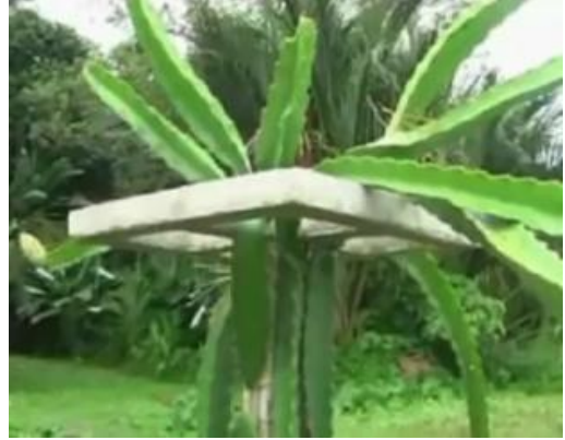
Hình 1.90. Trụ trồng thanh long tại Thái Lan bằng bê tông cốt thép.
