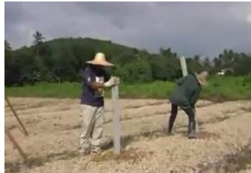
Hình 1.83. dựng trụ và lấp đất cố định
