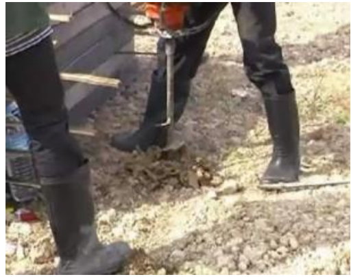
Hình 1.79. công nhân đang thao tác khoan lỗ trồng trụ
