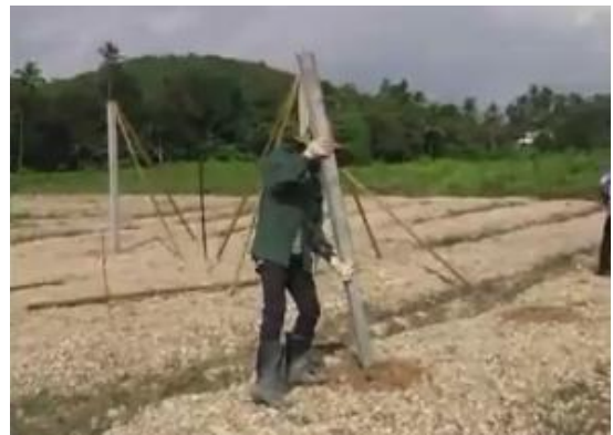
Hình 1.82. đặt trụ vào lỗ khoan
