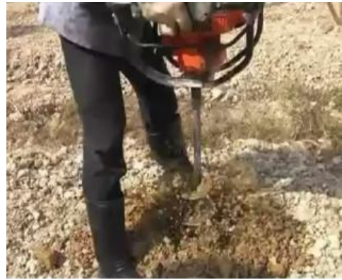
Hình 2.73. máy khoan độ sâu của lỗ chôn trụ trồng thanh long
