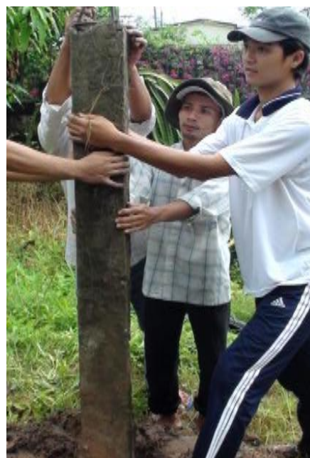
Hình 2.67. chuyển trụ đến nơi đào hố đặt trụ
