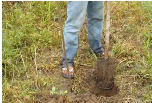
Hình 2.65. đào hố đặt trụ
