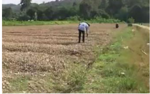
Hình 2.69. cắm cọc vị trí nơi đào hố đặt trụ
