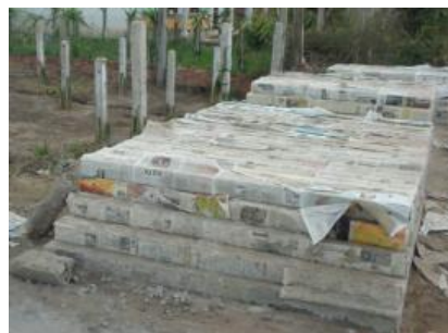
Hình 2.62. trụ bê tông cốt thép
