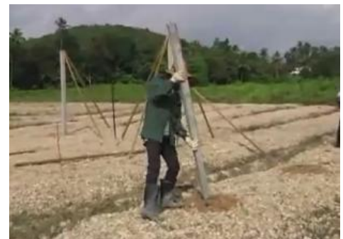
Hình 2.75. đặt trụ vào lỗ khoan
