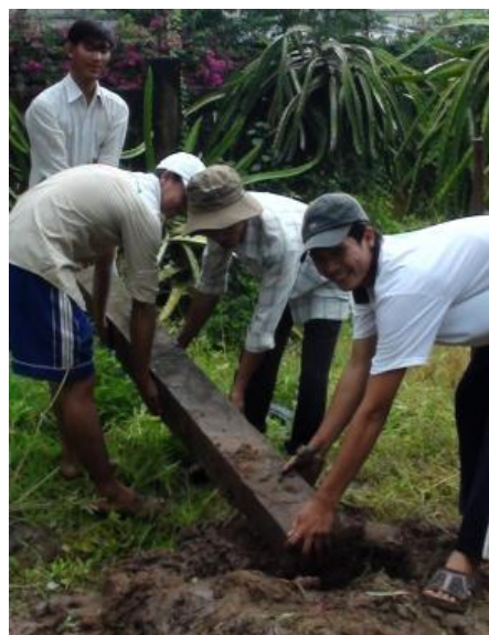
Hình 2.66. chuyển trụ đến nơi đào hố đặt trụ
