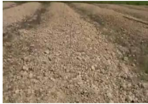
Hình 2.70. cắm cọc vị trí nơi đào hố đặt trụ
