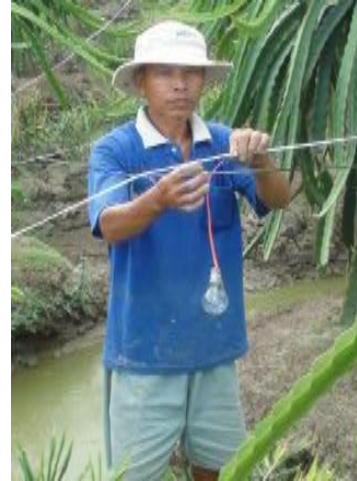
Hình 3.78. bóng đèn mắc vào nguồn điện xong không dùng băng dính cách điện.
