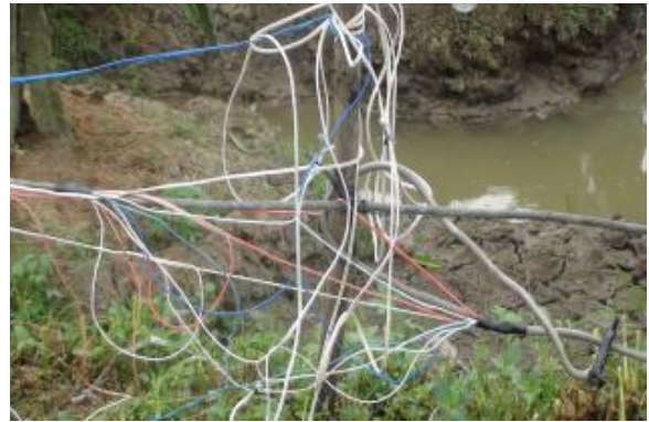
Hình 3.82. Hệ thống dây dẫn cách mặt đất khoảng 1 m
