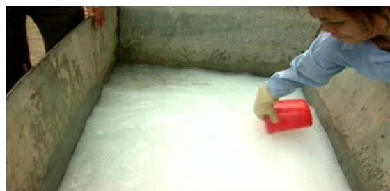
Hình 4.5. Đổ nước vôi vào bể xử lý
