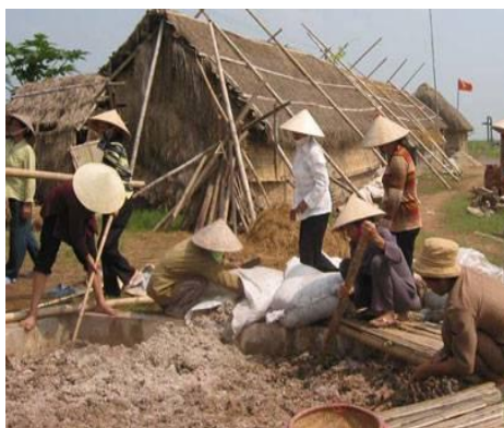
Hình 4.8. Cho bông hạt vào bể nước vôi
