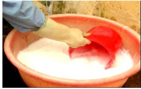
Hình 2.7. Hòa nước vôi
