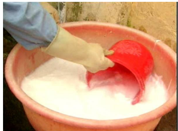
Hình 4.4. Pha nước vôi
