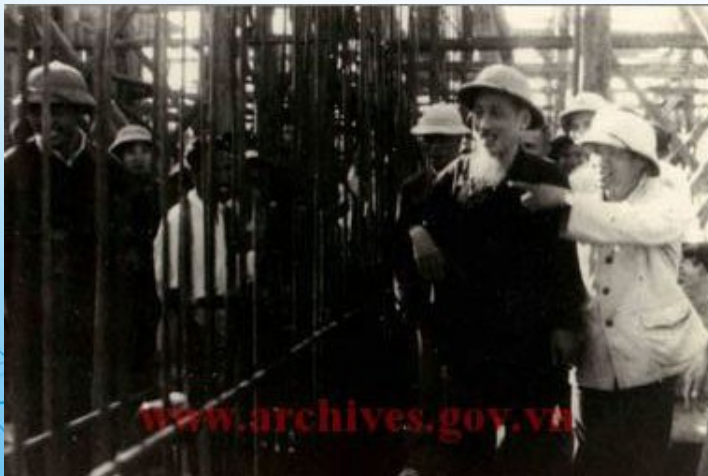
Chủ tịch Hồ Chí Minh thăm công trường xây dựng Công trình hệ thống thủy lợi Bắc - Hưng - Hải (công trình đại thủy nông lớn nhất miền Bắc Việt Nam) năm 1958.
