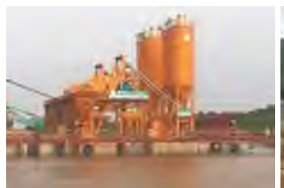
Trạm trộn bê tông lắp đặt trên xà lan
