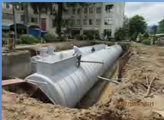
Sản phẩm vật liệu Composite (FRP) chế tạo bể xử lý nước thải chôn ngầm theo công nghệ AAOMBR Anaerobic (yếm khí) - Anoxic (thiếu khí) - Oxic (hiếu khí) - Membrane (màng lọc).
