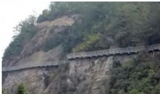
Cầu bám trên sườn núi đá để giảm thiểu đào nền đường.
