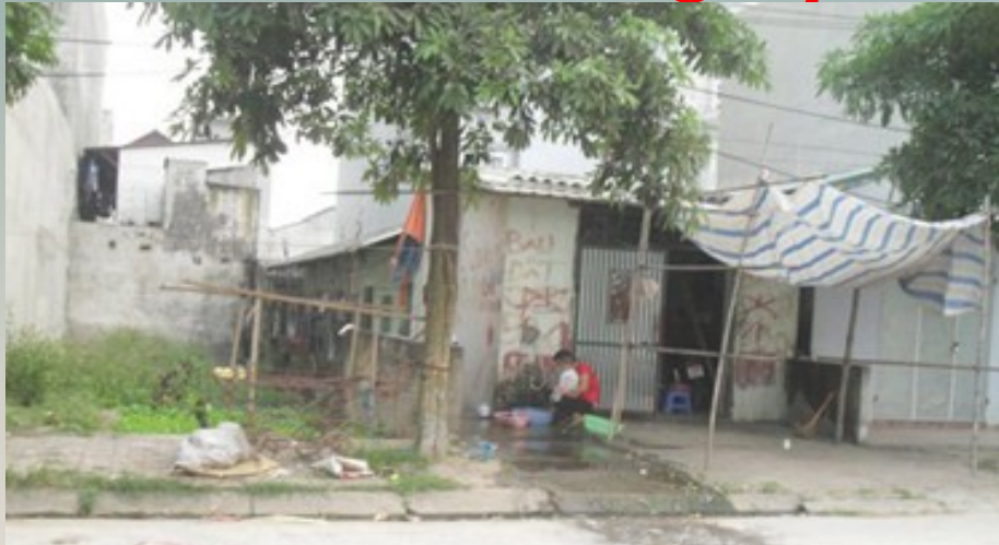
Nhà trọ lụp xụp tại khu công nghiệp Thăng Long
