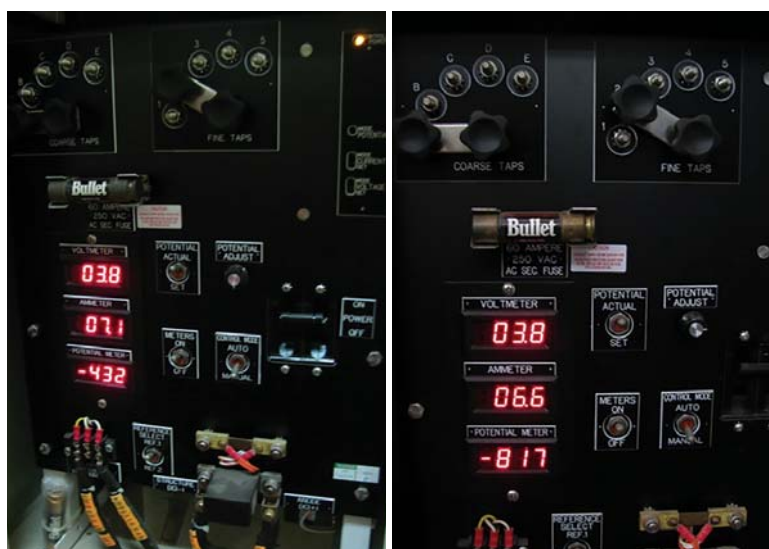
Hình 13. Điện thế bảo vệ cho đường ống nước làm mát Nhà máy Điện Nhơn Trạch 2
