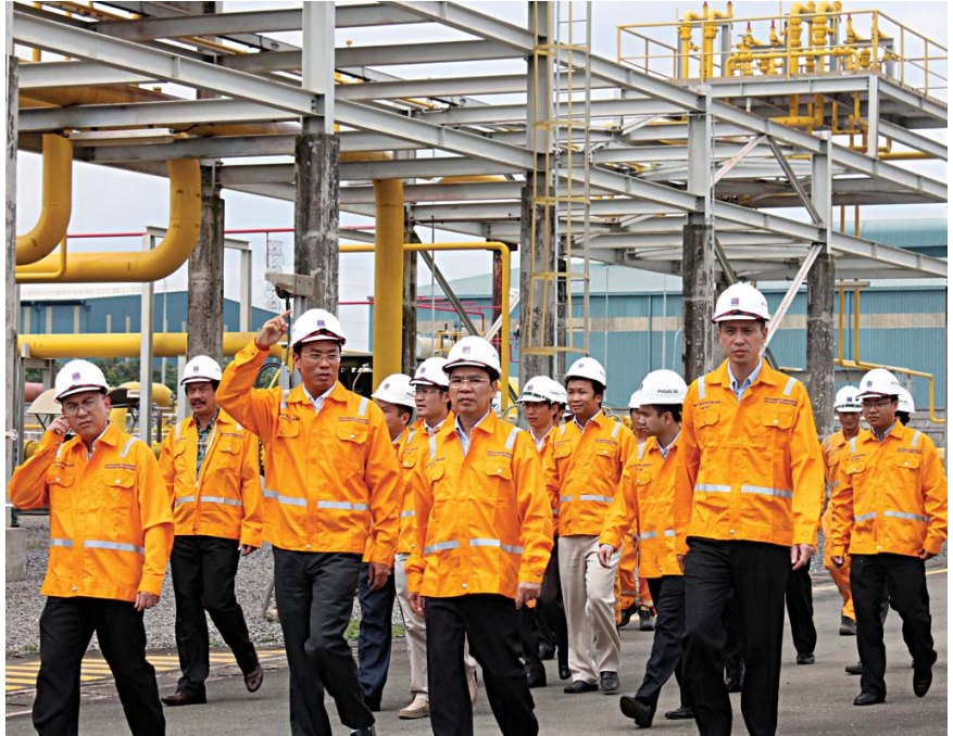
Lãnh đạo Tập đoàn Dầu khí Việt Nam làm việc tại công trình khí của PV GAS. Ảnh: PVN
