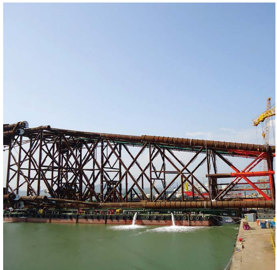
Chân đế giàn DH2 được vận chuyển và hạ thủy bằng sà lan chuyên dụng. Ảnh: VSP
