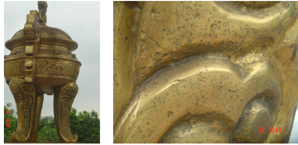
Hình 10. Ăn mòn lỗ trên bề mặt lu hương do lớp mạ không hoàn thiện (có nhiều lỗ châm kim) tạo nên chênh lệch điện thế giữa lớp mạ vàng và nền đồng
