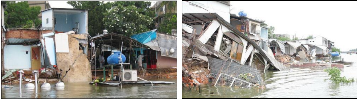
Hình 1. Sạt lở tại khu vực bán đảo TĐ, quận Bình Thạnh (Phụ nữ Online)
