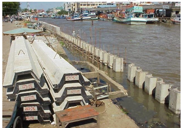
Giải pháp bảo vệ bê bằng cọc bê tông ứng suất trước
